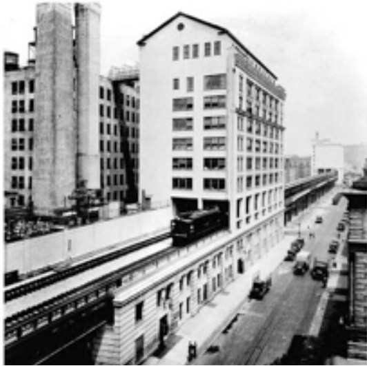
Figura 11. La antigua infraestructura ferroviaria
