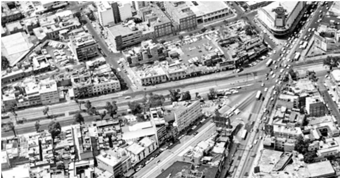
Toma aérea del cruce de Insurgentes, Génova y Avenida Chapultepec, antes del inicio de las obras de la Glorieta del Metro Insurgentes. Fuente: El Universal, 2015 "Las transformaciones de la Avenida Chapultepec", Colección Villasana-Torres, en http://www.eluniversal.com.mx/articulo/metropoli/df/2015/11/15/las-transformaciones-de-la-avenida-chapultepec
