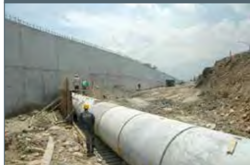
Fotografía 13 Relocalización de redes de alcantarillado en el marco del proyecto de extensión de la línea A del metro al sur del Valle de Aburrá
