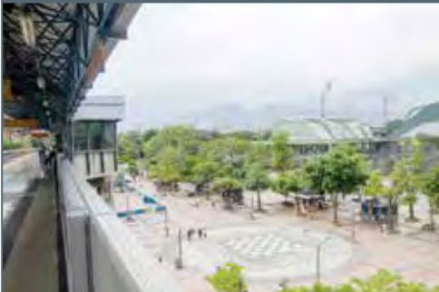
Fotografía 15 y 15a Urbanismo y paisajismo complementarios en la estación Estadio de la línea B
