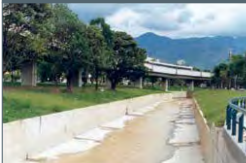
Fotografía 12 Canalización de la quebrada La Hueso
