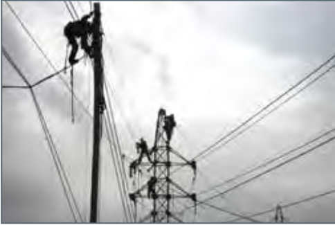
Fotografía 14 Relocalización de redes de energía
